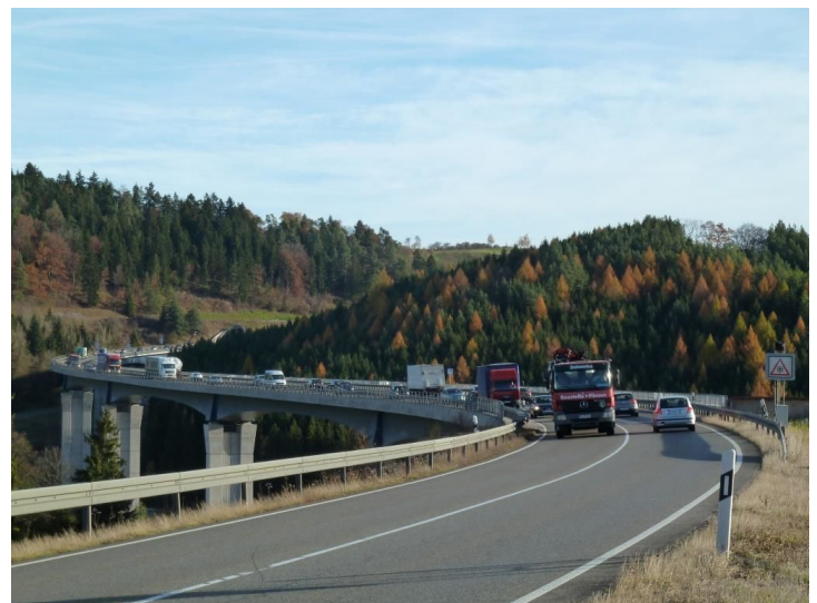
Die nördliche Gauchachtalbrücke. Der Bau einer zweiten Brücke wird jetzt in Angriff genommen. Foto: Flominator (talk). Wikipedia.
